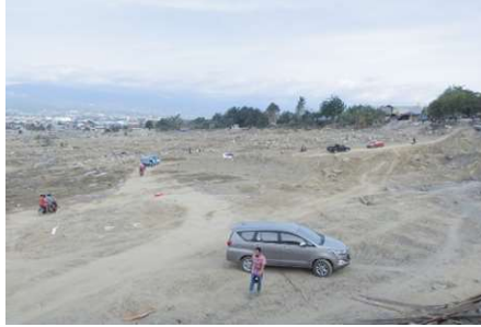
Fig. 38. Landslide at Balaroa.
